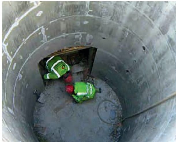
Ryc. 9. Prace związane z uszczelnieniem studni połączeniowej posadowionej na znacznej głębokości
