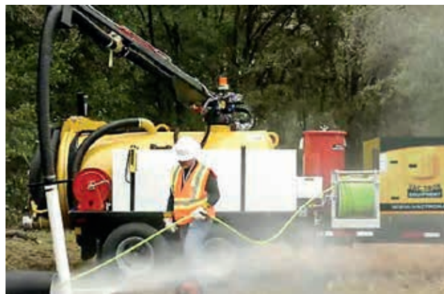
Ryc. 10. Urządzenie Vac-Tron do próżniowego wykonywania wykopów
